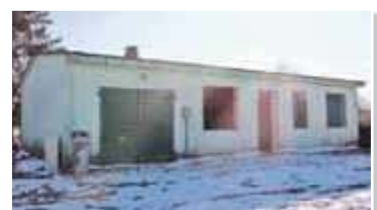
Budynek socjalny na stadionie sportowym w Wisznicach przed rewitalizacją
