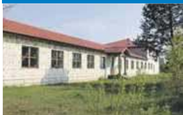
Budynek Zakładu Opiekuńczo-Leczniczego przed rewitalizacją
