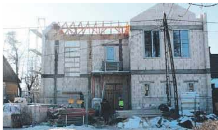
Budynek w centrum Wisznic w trakcie rewitalizacji
