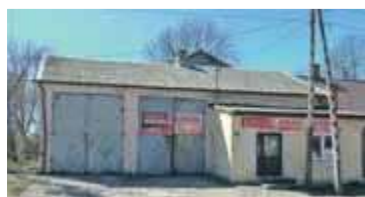
Budynek w centrum Wisznic przed rewitalizacją
