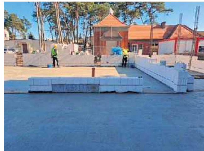
Wylano ławy fundamentowe, stanęły ściany.
