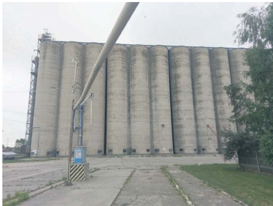
W elewatorze przy ul. Borowskiej w Strzelinie, rolnicy mogą przechowywać zboża
