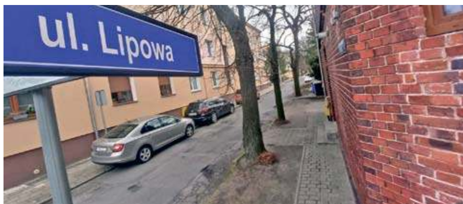
Wiele wskazuje na to, że ul. Lipowa w najbliższym czasie doczeka się remontu
