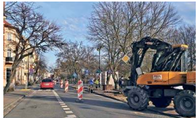
Pierwszy etap przebudowy rozpoczął się z końcem stycznia
