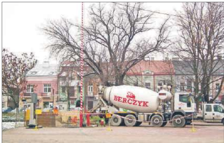
Na Rynku rozpoczęła się budowa fundamentów pomnika legionisty.
