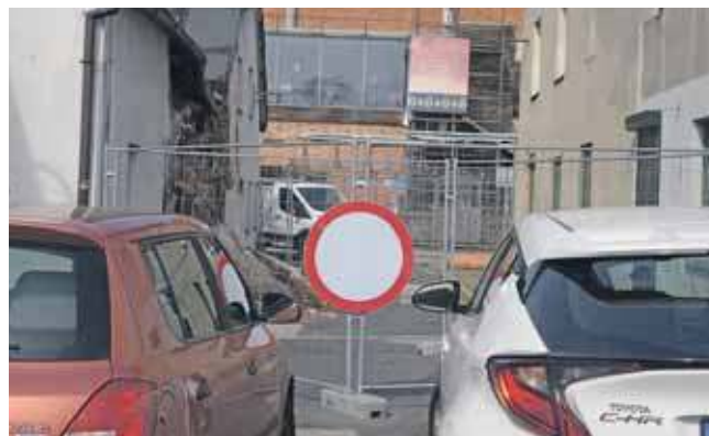
Mimo upływu blisko dwóch lat nie widać nawet światełka w tunelu, gdy chodzi o rozwiązanie tego problemu i przywrócenie ruchu na ul. T. Królika
