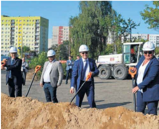
Pierwsza łopata na placu budowy nowej linii tramwajowej w Sosnowcu została symbolicznie wbita wczoraj
