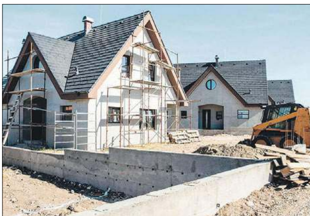
Po zmianach budowa domów jednorodzinnych na własne potrzeby, o powierzchni zabudowy poniżej i powyżej 70 mkw., będzie możliwa na podstawie uproszczonej procedury
