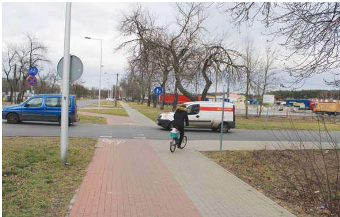
Obręb skrzyżowania i przejścia dla pieszych blisko Dino to niebezpieczne miejsce
