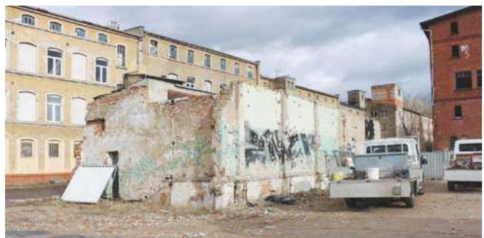
W ubiegłym tygodniu prace zaczęły się od rozbiórek trafostacji
