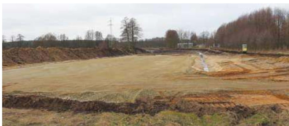
Po budowie drogi uzbrojone zostaną kolejne setki hektarów ziemi
