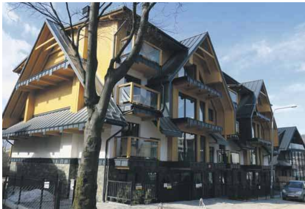
Wzdłuż budynku przy ulicy Modrzejewskiej zamiast chodnika zrobiono miejsca parkingowe.
