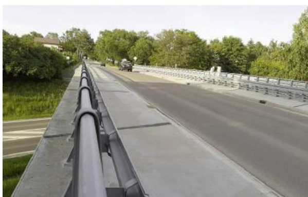
Wiadukt na ul. Domanickiej zostanie zamknięty w listopadzie
