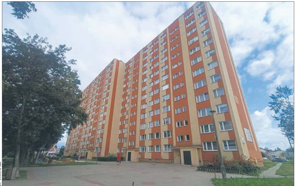
Blok przy ul. Mickiewicza 19
