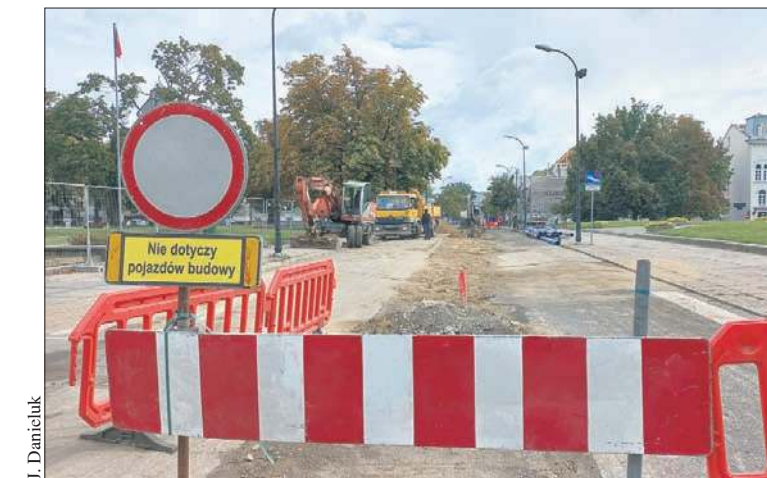
Przebudowa kanalizacji na ul. Kościuszki i pl. Dąbrowskiego ma potrwać do końca tego roku. Dłużej przyjdzie płocczanom poczekać na oddanie ulic do ruchu
