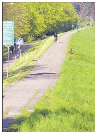
Prace przy wałach rozpoczną się najwcześniej na wakacjach.
