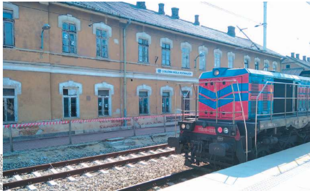
Budynek dworca kolejowego w Rozwadowie powstał w latach osiemdziesiątych XIX wieku
