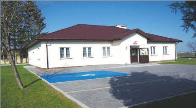
Wybudowana Świetlica w Strzelcach-Kolonii
