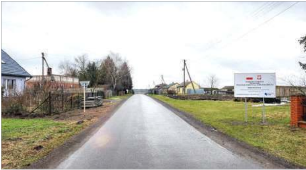
Zmodernizowana droga gminna w Strzelcach
