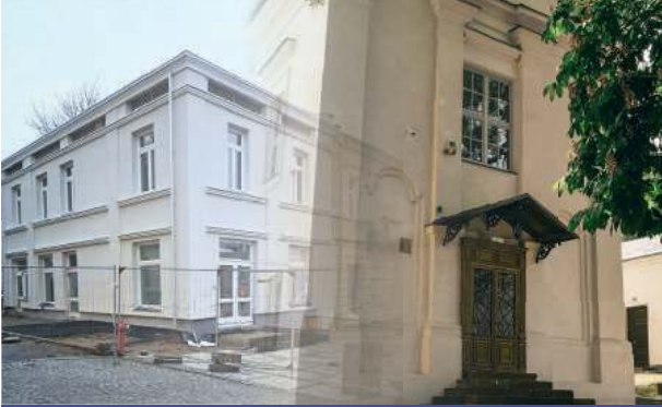
Budynek wyjścia z Chełmskich Podziemi Kredowych
