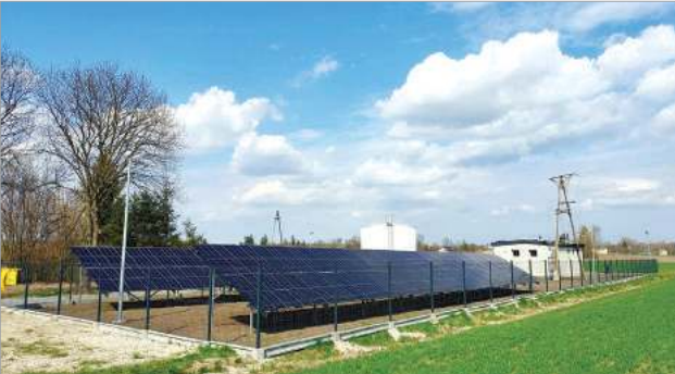
Zmodernizowane ujęcie wody w Białopolu
