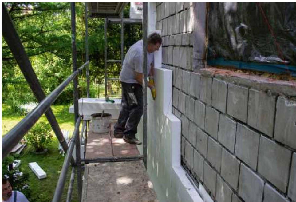
🔧 Termomodernizacja to zarówno docieplenie ścian... AUSTROTHERM
