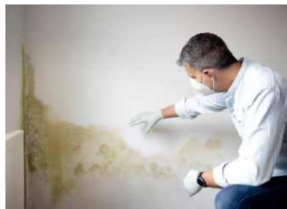
❗ Wilgoć w przegrodach z czasem może prowadzić do pojawienia się zapachu stęchlizny, rozwoju pleśni i innych grzybów. ŚNIEŻKA
