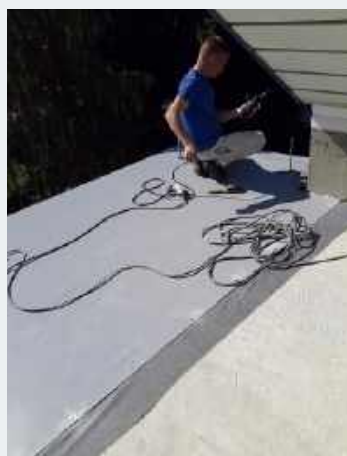
🔧 Izolację przeciwwilgociową z PVC ułożono na macie podkładowej. Płyty zgrzewano.
