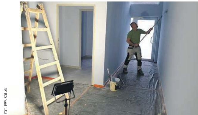
Mariusz Malik z firmy remontowej przy malowaniu ścian w pogotowiu ratunkowym
