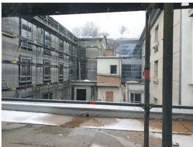
Nowy budynek z lewej strony połączony z istniejącym obiektem
