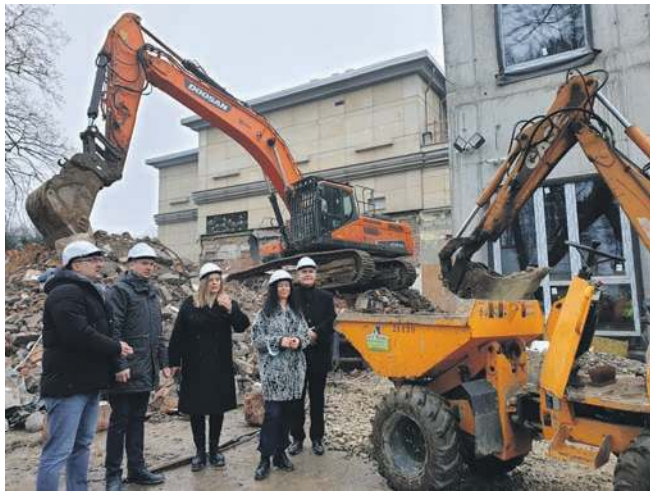
Właśnie skończyło się wyburzanie starej kotłowni, gdzie powstać ma jeszcze jeden budynek. Goście oglądali plac budowy
