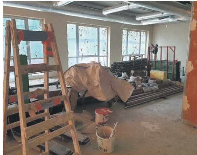
W tym pomieszczeniu znajdzie się sala do kinezyterapii
