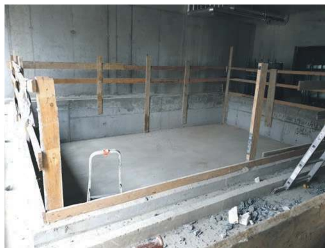
Niecka basenowa w nowym budynku
