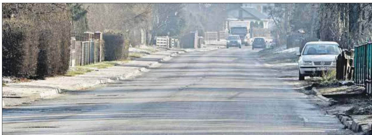
Dzięki rządowej dotacji zmodernizowany zostanie odcinek od Al. Solidarności do rogatek miasta (w kierunku Czosnówki)
