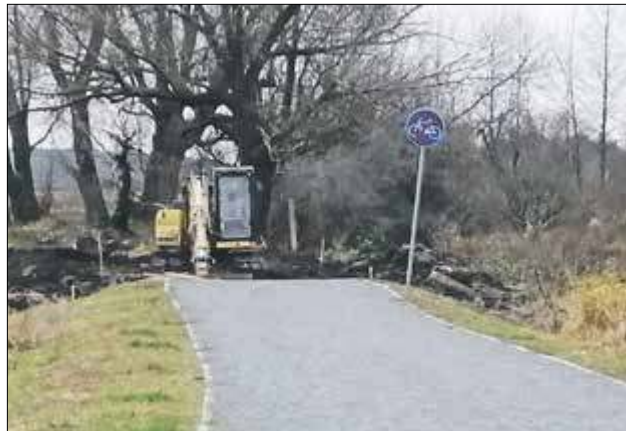
Przetarg na dalsze prace przy ścieżce pieszo-rowerowej wzdłuż Krzny rozstrzygnięto z końcem czerwca. Prace w terenie ruszyły niedawno
