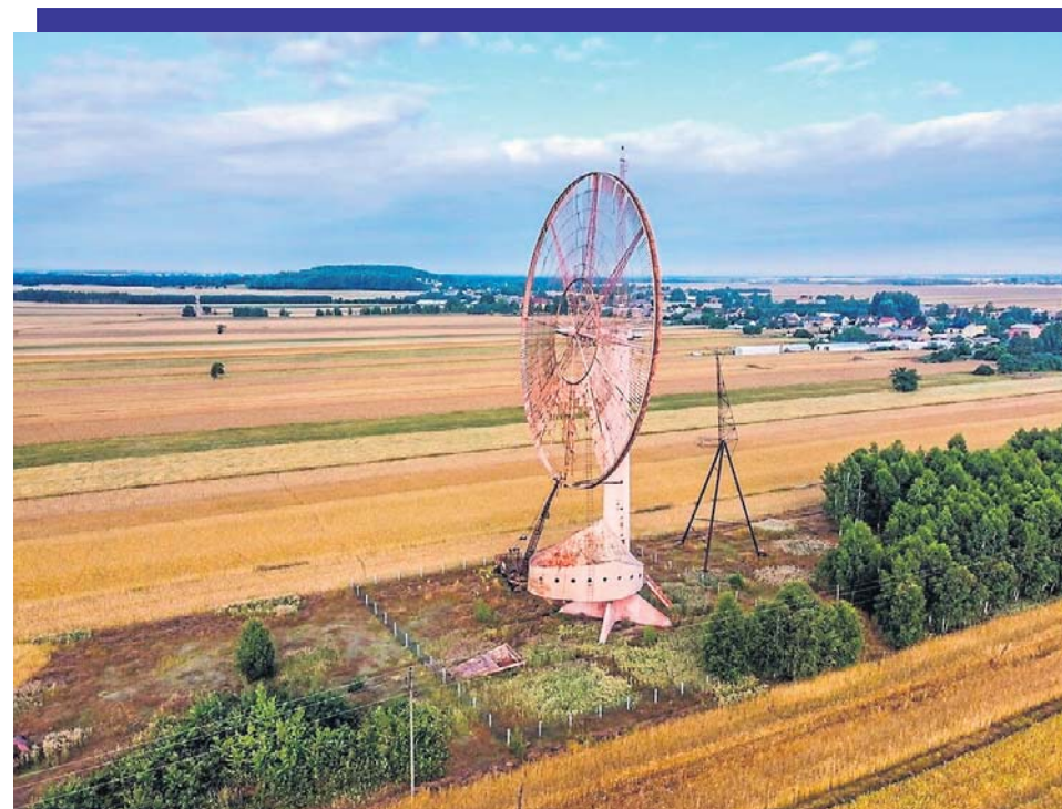
Konstrukcja na polu w podkłobuckiej wsi ma 54 metry wysokości. Jest lokalną atrakcją, ale także dowodem na to, że można i trzeba marzyć.
