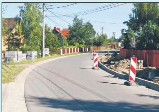
Trwa budowa chodnika w kierunku Góry Śmierci.
