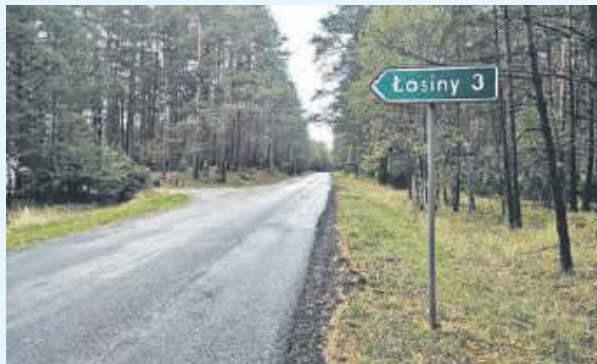
Powstanie kolejny odcinek drogi do Łosin
