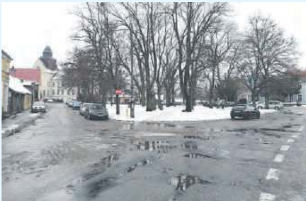
Plac Zamkowy zostanie gruntownie przebudowany.
