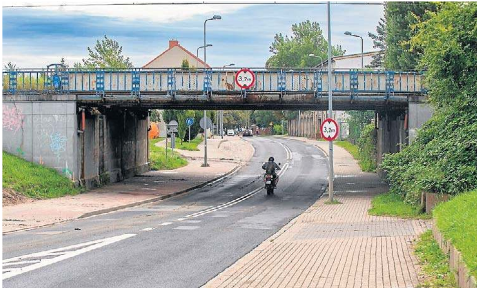
Od 4 września przejazd i przejście pod wiaduktem na ulicy Grunwaldzkiej będą niemożliwe
