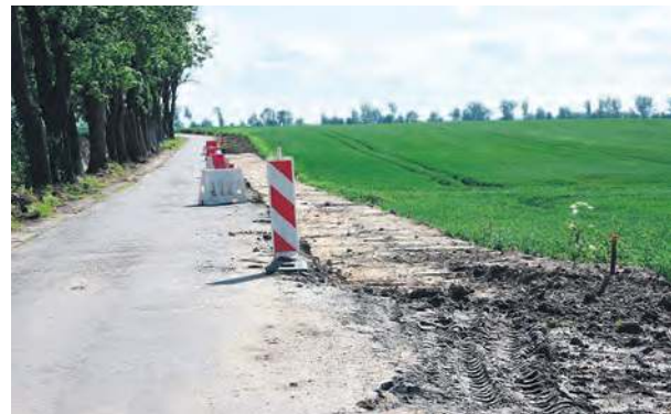
Na drodze powiatowej, na odcinku Raciąż – Piastoszyn prace związane z przebudową już się rozpoczęły.
