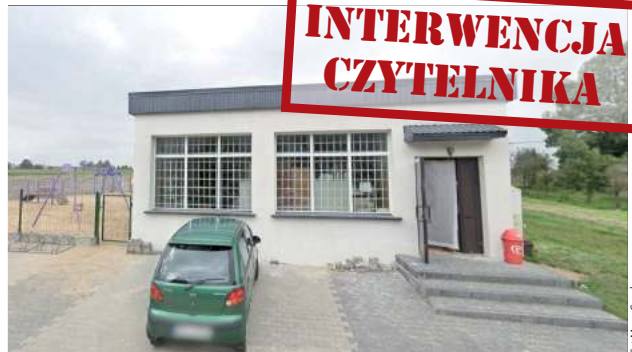
Z zewnątrz budynek jest odnowiony, ale w środku wymaga gruntownego remontu
