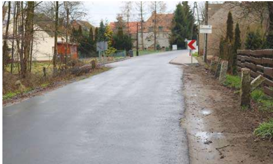
W tym roku dokończony zostanie remont drogi przez Miłaków
