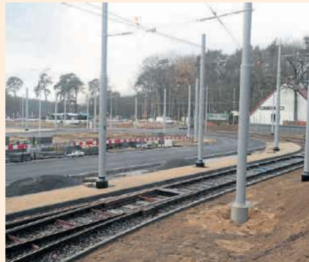
30 listopada zakończył się jeden z ważnych etapów budowy węzła, dlatego tramwaje znów jeżdżą na pętli Głęboke
