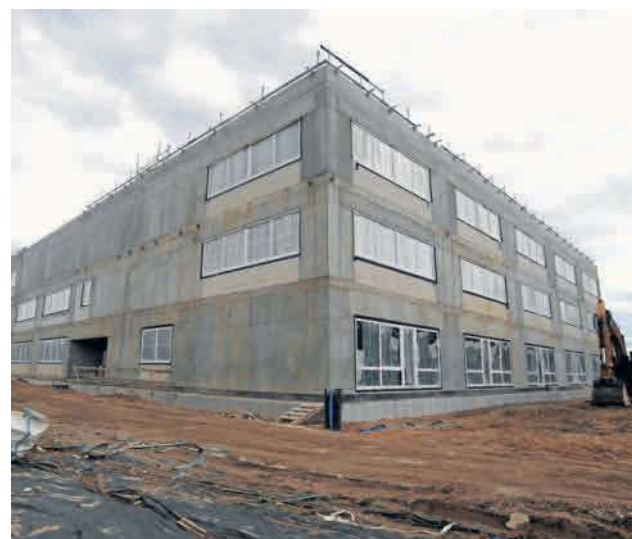
Warszewo to najprężniej rozbudowująca się dzielnica, dlatego budowana szkoła jest już drugą w ostatnich latach
