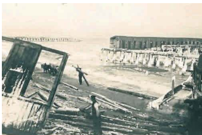
Zniszczone łazienki kąpielowe na Westerplatte - 10.01.1914 r.
