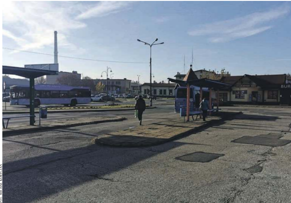
W tym miejscu ma powstać centrum przesiadkowe
