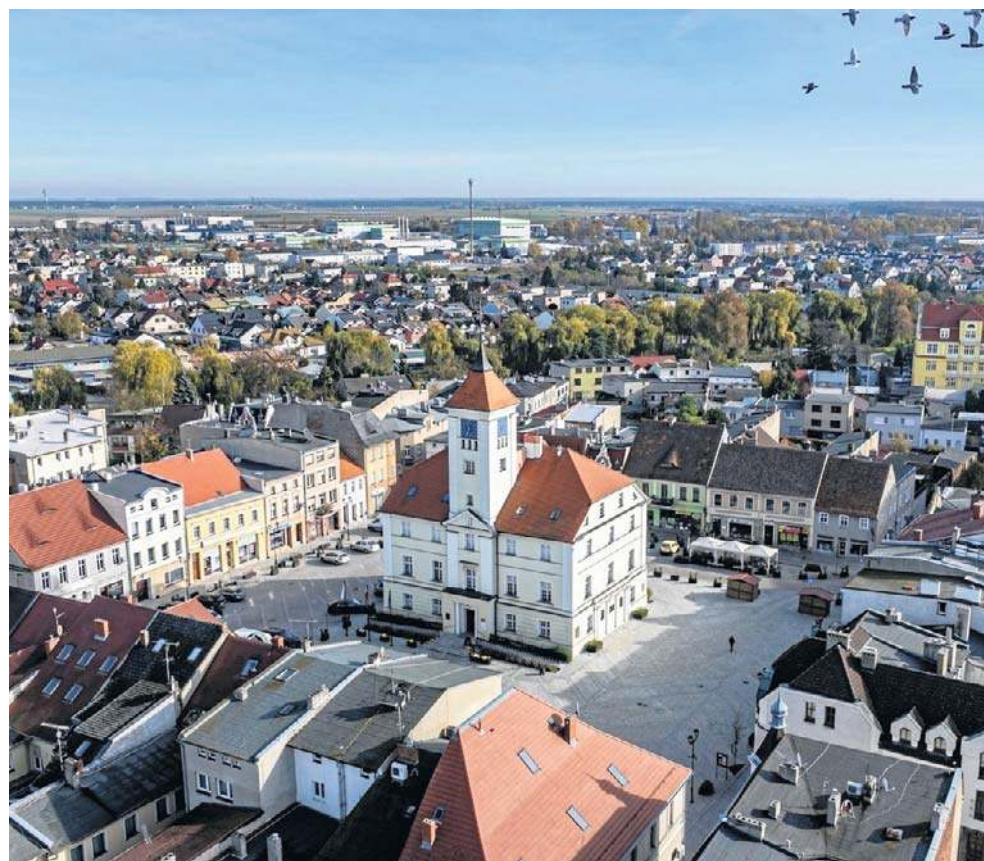
Obwodnica ma odciążyć komunikacyjnie miasto
