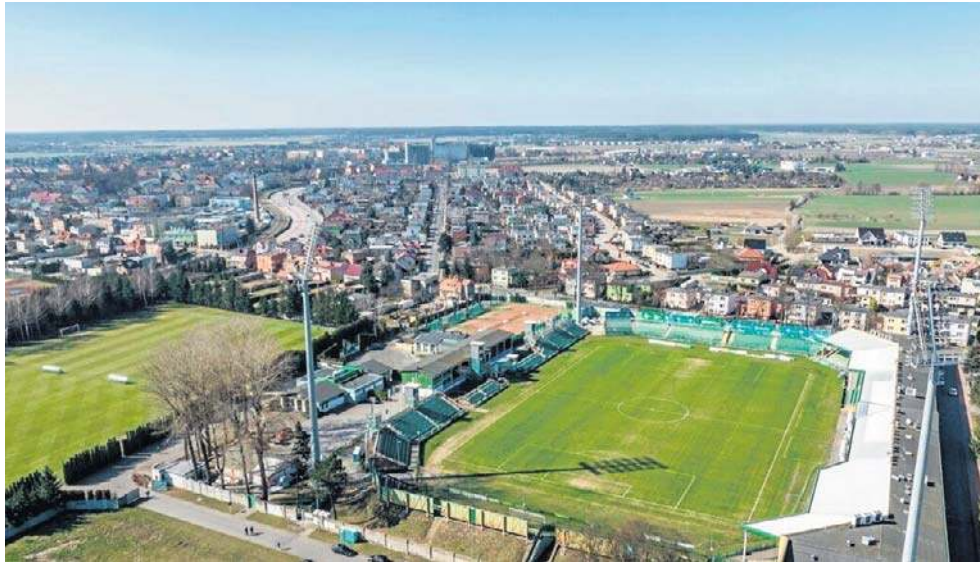
Siedziba Ośrodka Sportu i Rekreacji mieścić się będzie w Grodzisku Wielkopolskim przy ul. Powstańców Chocieszyńskich 52 (to teren stadionu w tej części, która należy do miasta)
