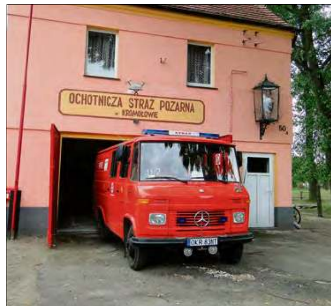
Wokół istniejącego budynku nie ma już miejsca na dodatkową infrastrukturę.
