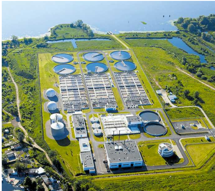
• Oczyszczalnia ścieków Pomorzany w Szczecinie
