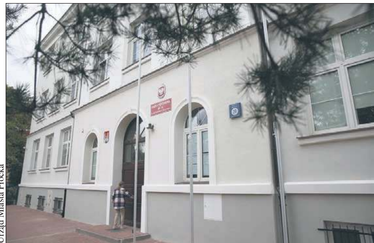
Elewacja SP 14 po remoncie
