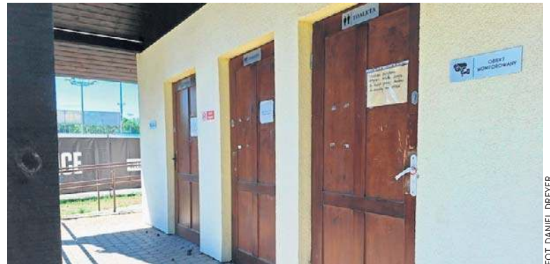
Trzy toalety przy cmentarzu, a wszystkie zamknięte. Po tym jak napisaliśmy o problemie... zdjęto oznaczenia, że to WC
