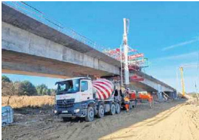
W czwartek, 5 marca zabetonowano ostatni segment konstrukcji drugiej jezdni. obwodnicy Morawicy.
