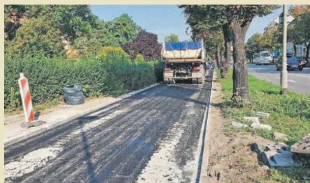
Trwają prace przy przebudowie ciągów pieszo-rowerowych wzdłuż ul. 3 Maja (na odcinku od skrzyżowania z ul. B. Chrobrego do skrzyżowania z drogą krajową nr 94 - ul. Andersa). W ubiegłym tygodniu układano masę bitumiczną
