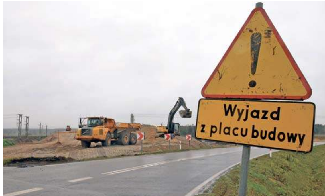
W miejscu, w którym trwają prace, kierowcy są proszeni o szczególną ostrożność
