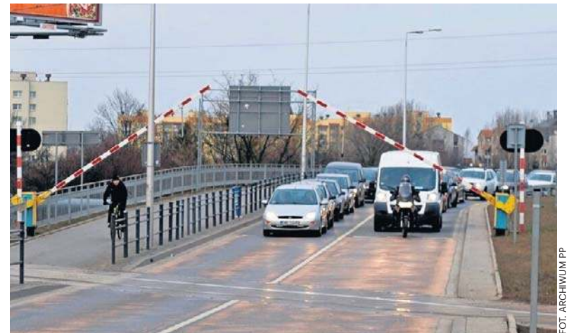
Ten przejazd uważany jest za niebezpieczny i mocno utrudnia ruch
