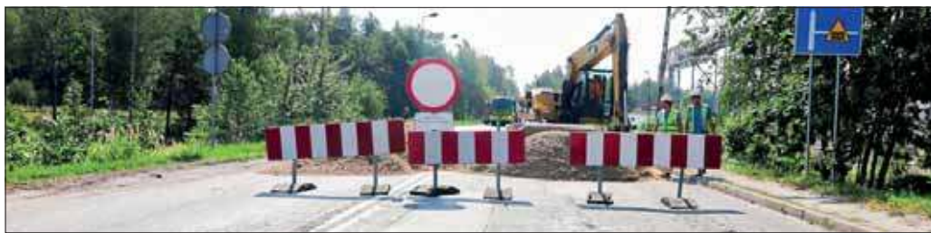
Remont drogi potrwać ma 3 miesiące
