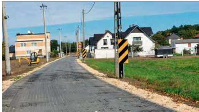
W ramach inwestycji utworzono nową nawierzchnię z kostki betonowej.
