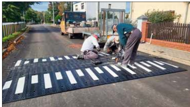
Jednym z ostatnich etapów prac był montaż progu zwalniającego.
