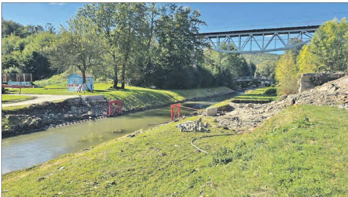
Woda porwała kładkę przy łowisku obok mostu kolejowego w Moszczance
