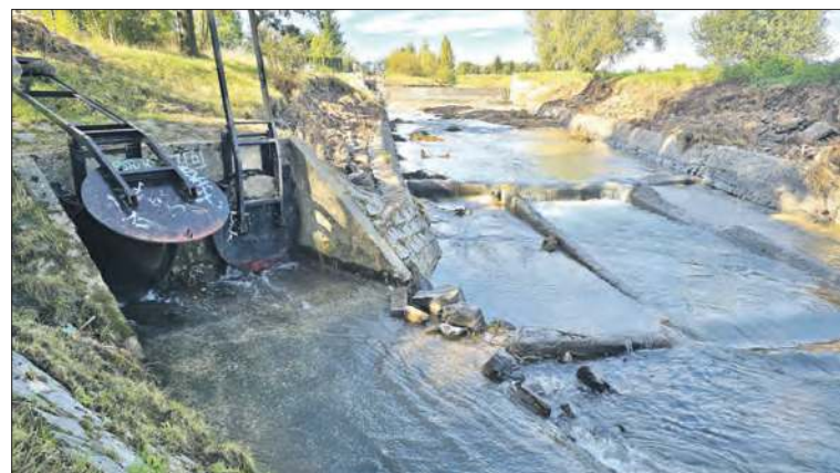
Za jazem w Prudniku woda wymyła spore fragmenty nabrzeża. Kamienne brzegi w większości wytrzymały, ale są za niskie.
