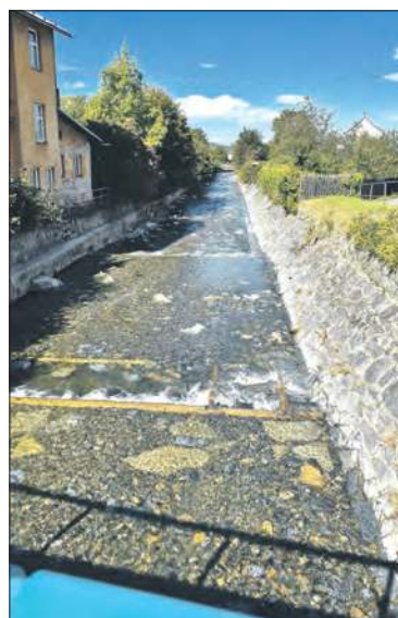
W śródmieściu Złatych Hor Złoty Potok jest solidnie obetonowany. Rzeka na tym odcinku pozbawiona jest zakrętów.
