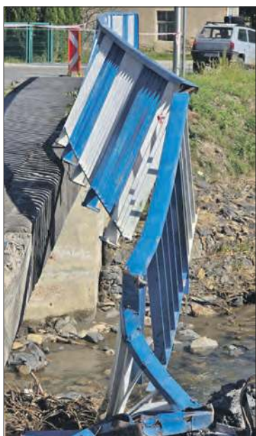
Oberwana przez wodę barierka na moście drogowym w Jarnołówku
