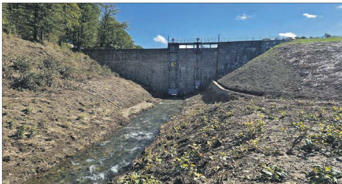
Zapora w Jarnołówku po raz kolejny uratowała mieszkańców miejscowości nad Złotym Potokiem przed ekstremalnie wysoką wodą.
