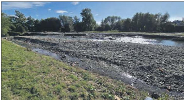
Ogromna, kamienna łacha w Moszczance to również świadectwo zniszczeń. Woda wymyła ziemię.
