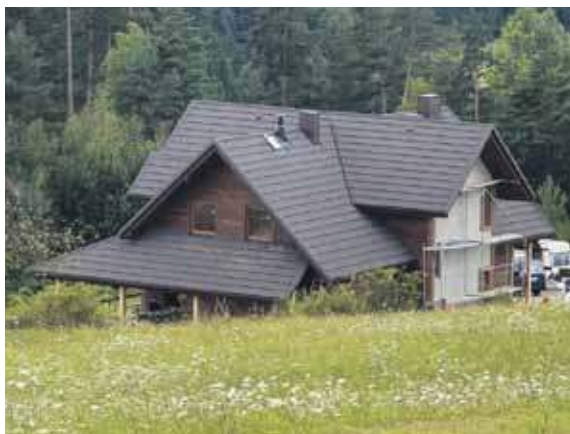
Samowola budowlana w Harklowej
