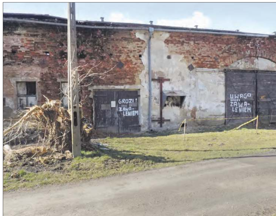
Historyczna, przyzamkowa zabudowa gospodarcza
