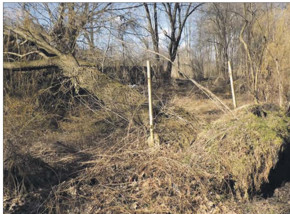
Jedno z kilku powalonych na mur ogrodzeniowy drzew przy ul. Zamkowej
