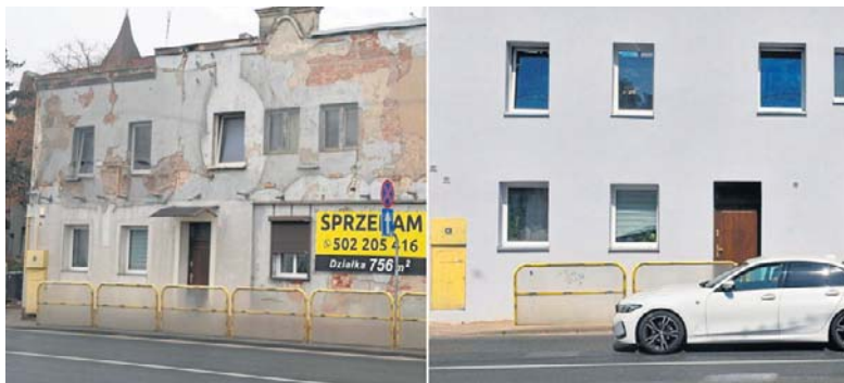
Budynek u zbiegu ulic Lubickiej i Gołębiej w Toruniu. Po lewej stronie - stan na grudzień 2025 roku. Po prawej stronie - stan na sierpień 2026 roku
