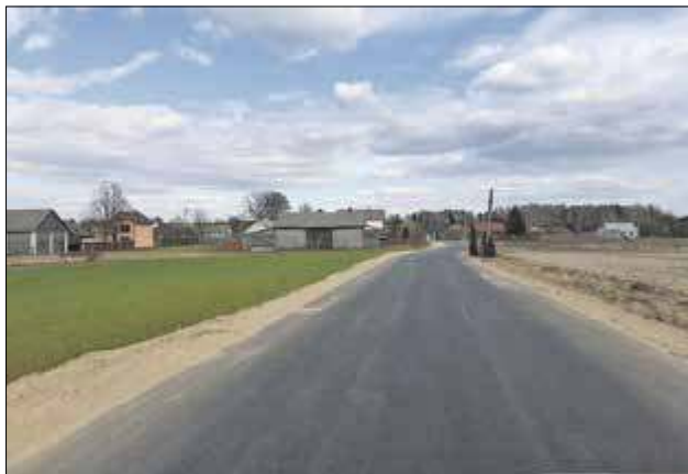
Na chwilę obecną na trasie Sitno - Szachy o długości 4 km 156 m została wykonana podbudowa oraz wyłożona pierwsza warstwa dywanu asfaltowego
