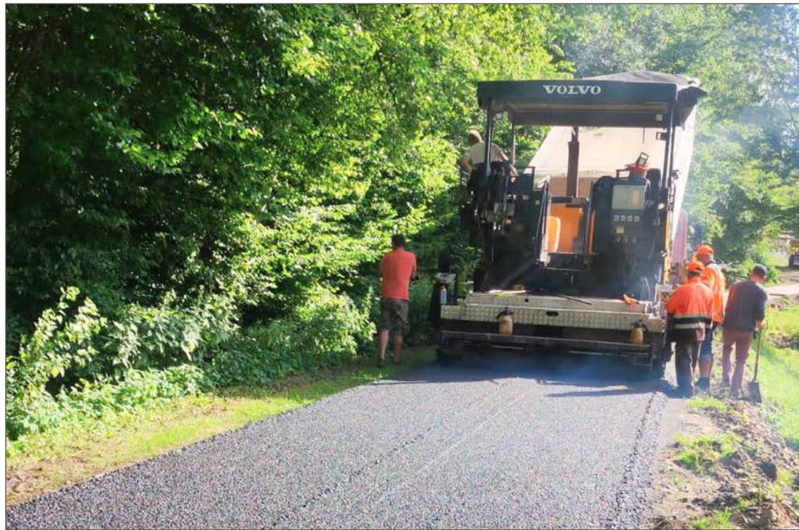
W ubiegłym roku wyremontowano we wszystkich miejscowościach blisko 16 kilometrów dróg.
