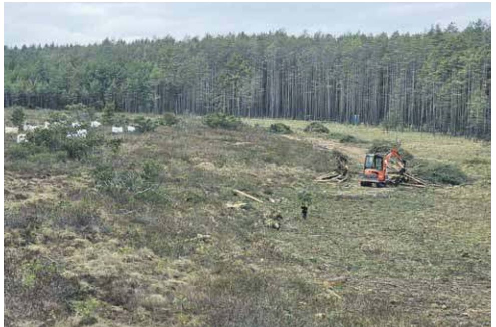
Trudno się przyzwyczaić do widoku z platformy - kopuły oczyszczonej z drzew i krzewów.
