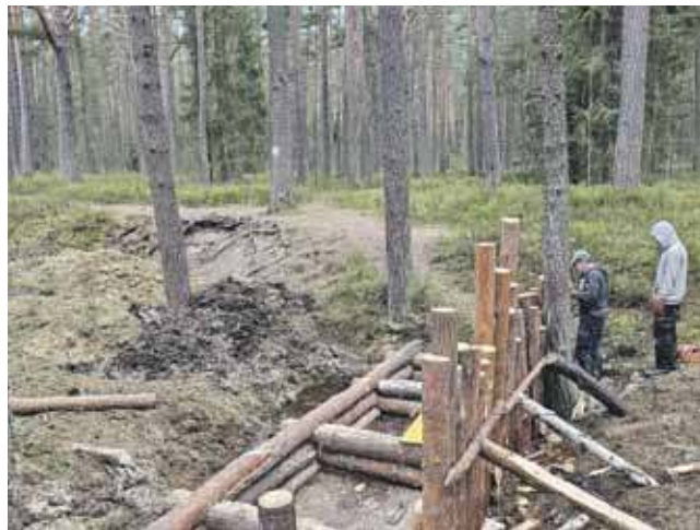
Po płynącym przez rezerwat strumyku nie ma już śladu. Został zasypany.
