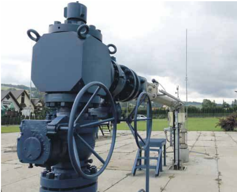
Z Bańskiej do Suchego i Poronina zaledwie parę kilometrów, a jednak trzeba wielomilionowych nakładów, by geotermia do- tarła do tutejszych domów.
