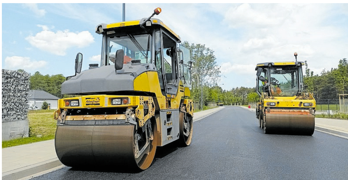
• Remont ul. Kąty Grodzkie na Zielonej Białolece. Układanie asfaltu w maju 2025 r. FOT. ZARZĄD ROZBUDOWY MIASTA
