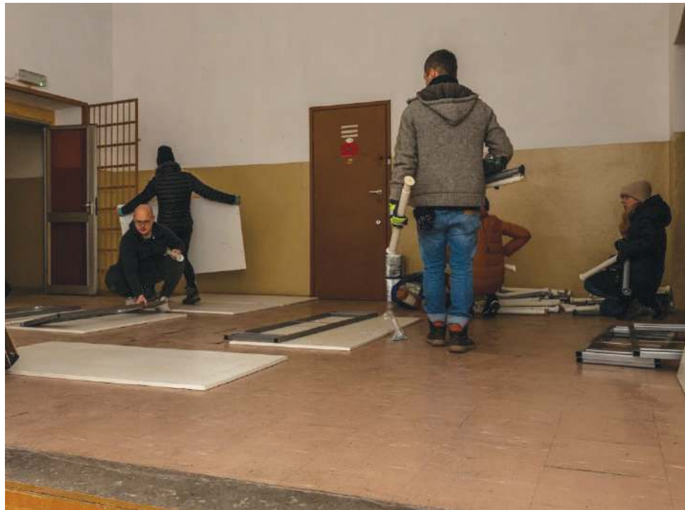
W koszarach codziennie pracują ekipy remontowe
