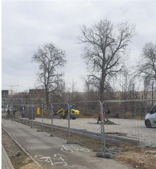
Wznowiono prace przy budowie boiska na Osiedlu nr 9
