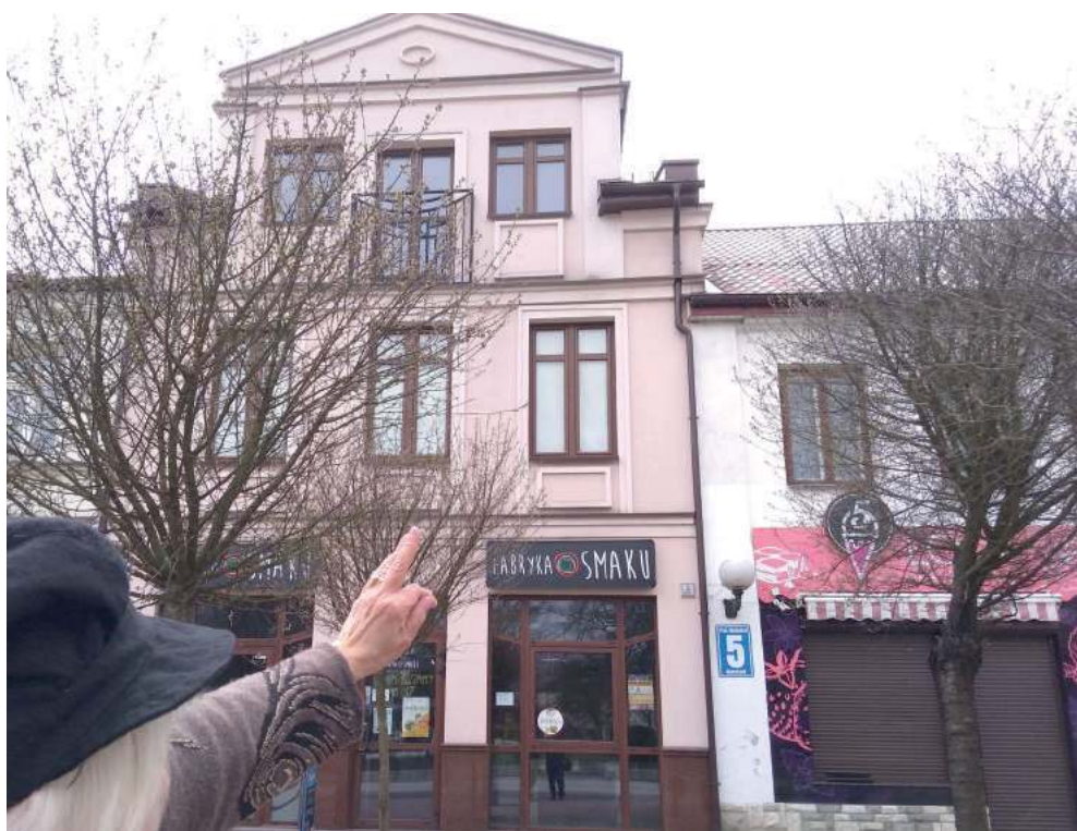
Gołym okiem widać, że komin i nadbudowany fragment kamieniczki sąsiada „wchodzi” na budynek Grażyny Waszczuk (nr 5)
