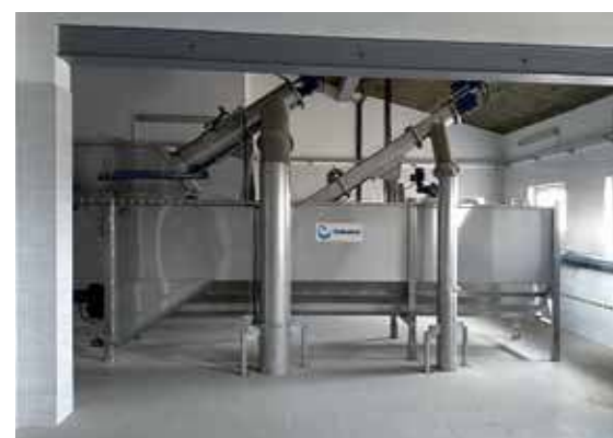
Zamontowany sitopiaskownik w nowym pomieszczeniu hali
