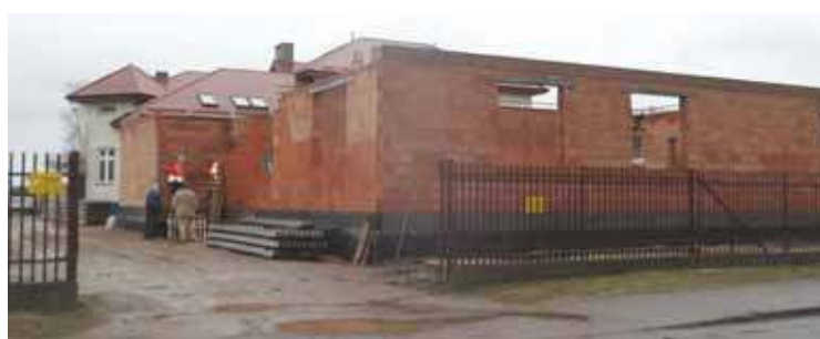
Rozbudowa obiektu SP w Dzierzgowie
